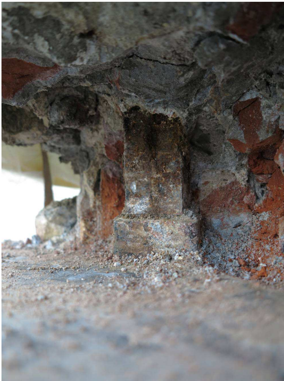
Fot. nr 19. Figura podczas demontażu w roku 2016. Widoczny korodujący trzcień stalowy z obmurowaniem ceglanym.
