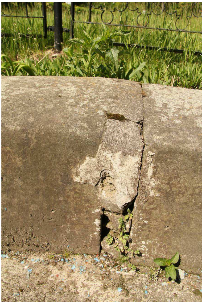
Fot. nr 45. Zniszczone wtórne wypełnienia na łączeniach elementów obramowania niecki.
