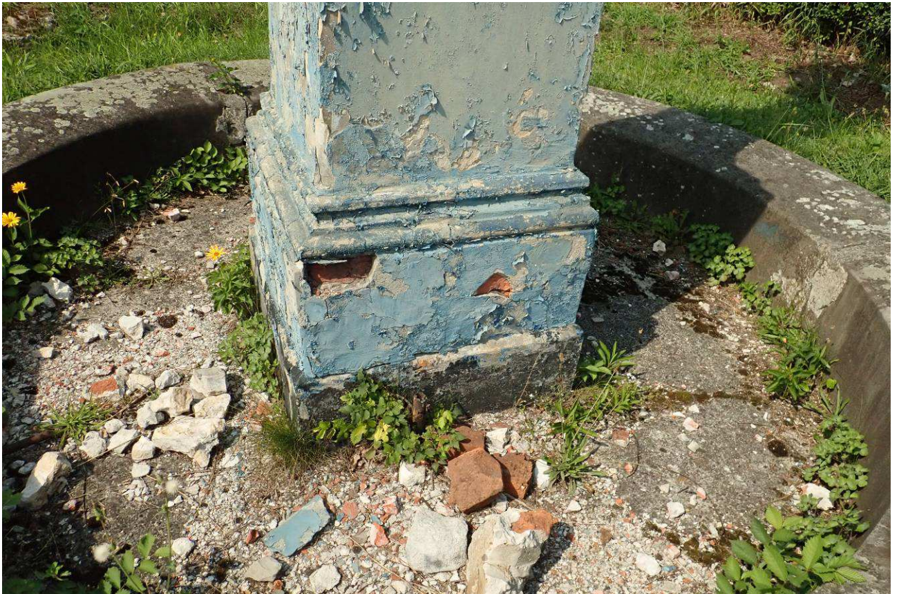
Fot. nr 37. Podstawa cokołu od strony tylnej. Czytelne głębokie ubytki struktury. Widoczna pozostałość instalacji odwadniającej.
