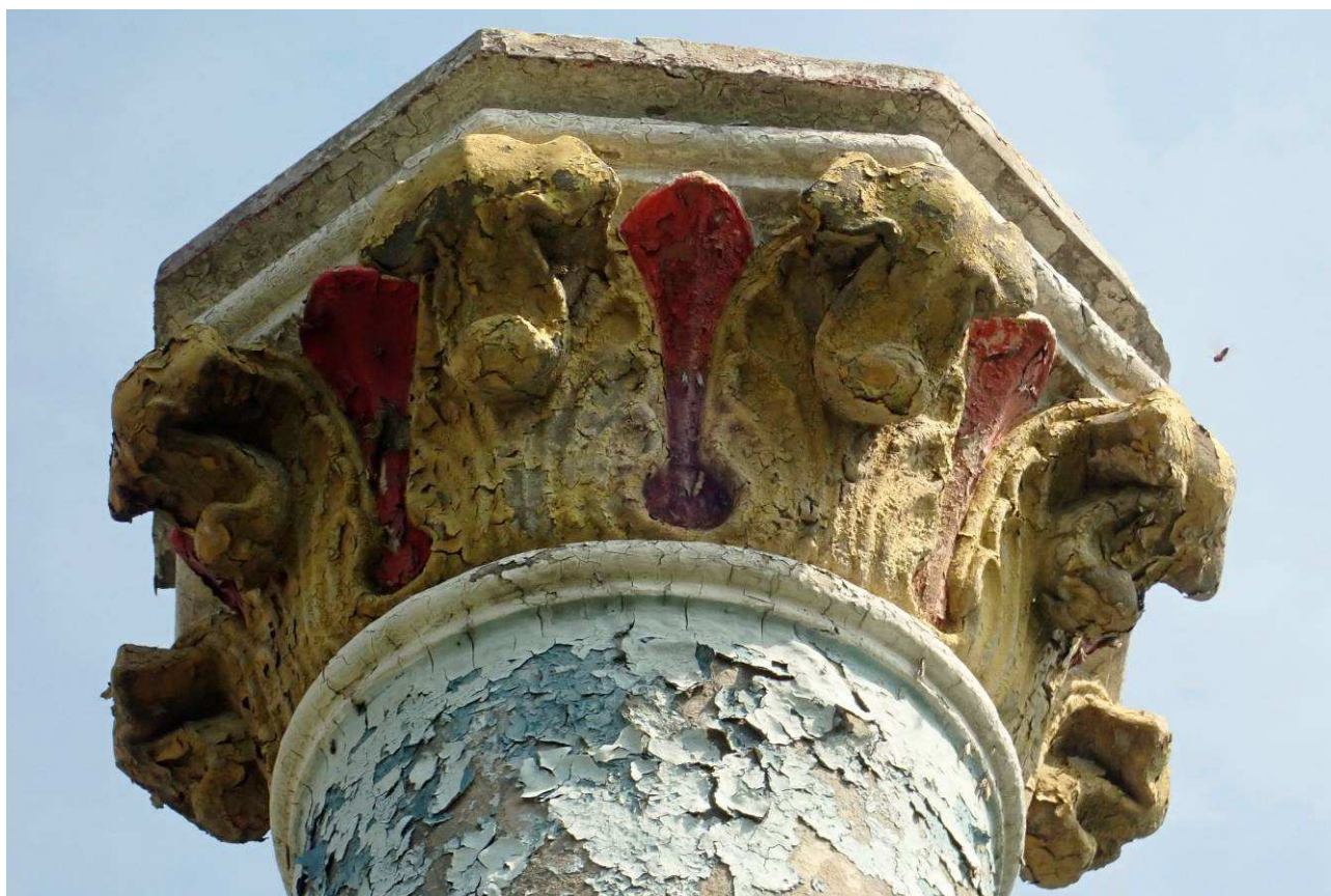
Fot. nr 30. Stan zachowania kapitela. Widoczne spękania i deformacje abakusa.
