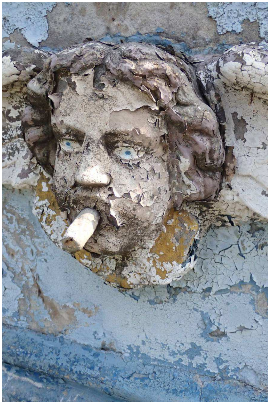
Fot. nr 35. Stan zachowania dekoracji postumentu z pozostałością tryskacza fontanny.
