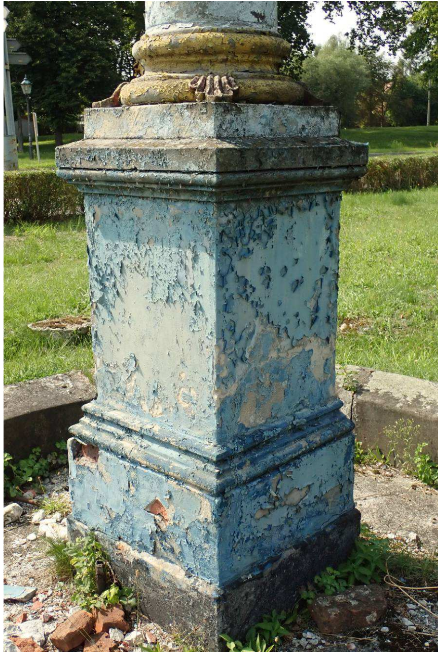
Fot. nr 32. Stan zachowania podstawy kolumny. Widoczne głębokie ubytki, sięgające struktury murowej.
