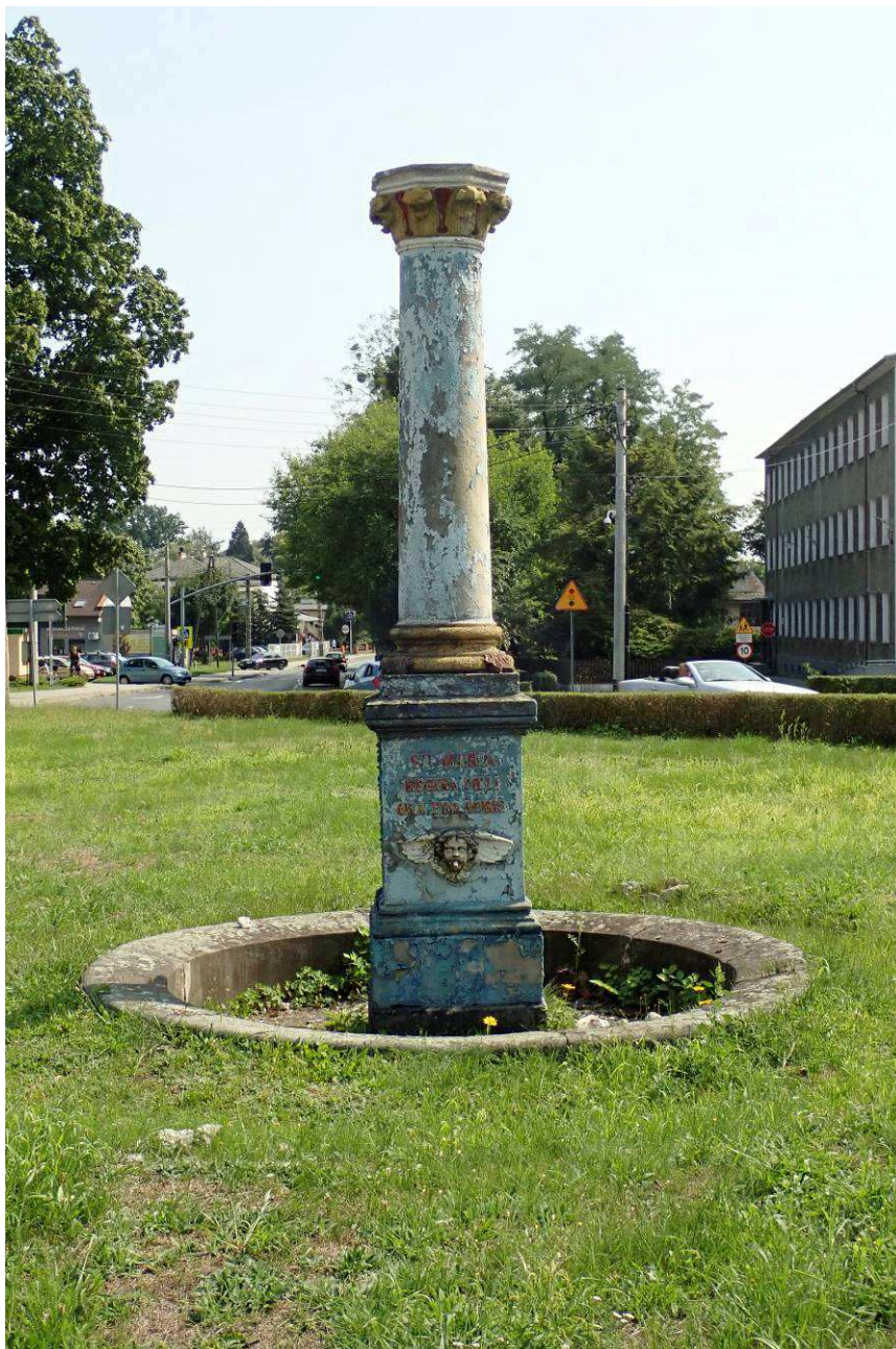
Fot. nr 27. Stan zachowania niecki i kolumny. Widok od strony północnej. Czytelne nadsypanie powierzchni gruntu i pogrążenie niecki.
