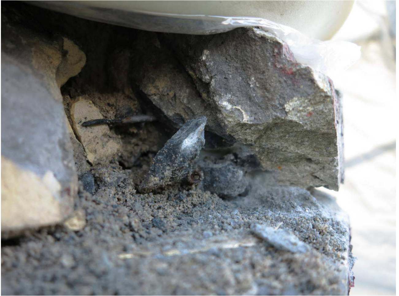
Fot. nr 17. Baza figury. Stan podczas demontażu w roku 2016. Czytelne korodujące zbrojenie uzupełnień ubytków oraz mokre, zdeintegrowane zaprawy.
