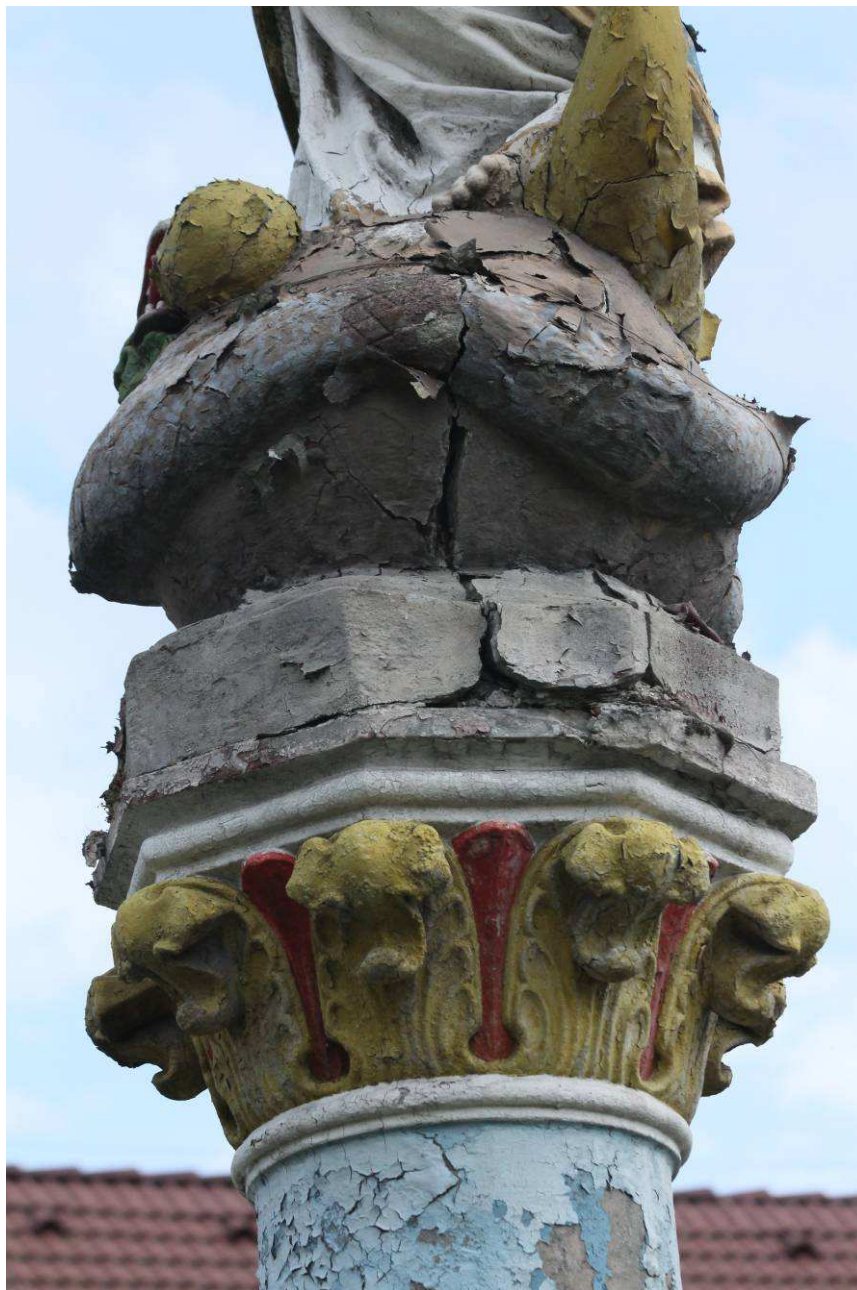
Fot. nr 13. Stan zachowania figury Maryi przed demontażem w roku 2016. Widoczne spękania i deformacja podstawy.
