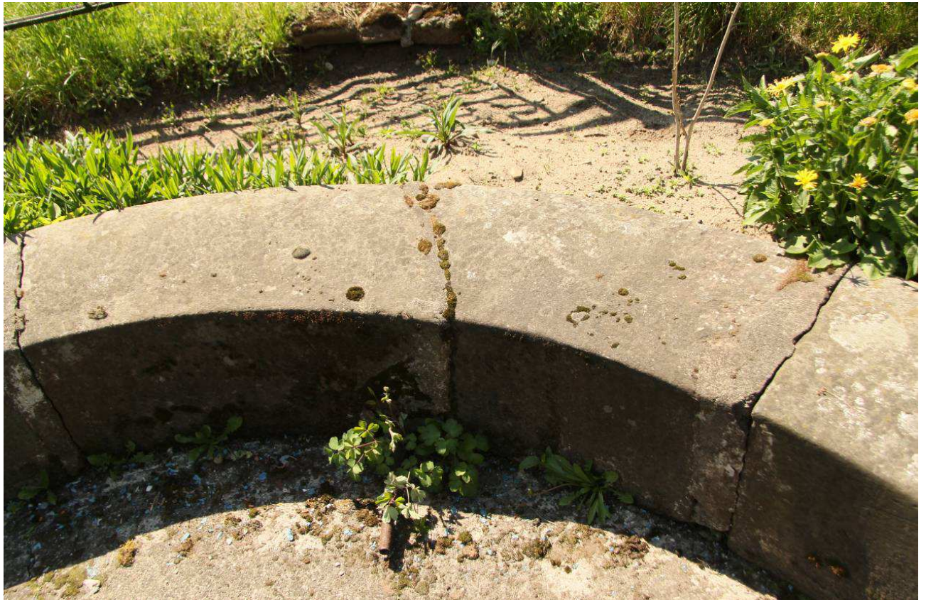
Fot. nr 41. Spękania i deformacje obramowania niecki. Widoczne kumulacje zasolenia i krystalizacji wodorowęglanu wapnia w strefach spękań kamienia.
