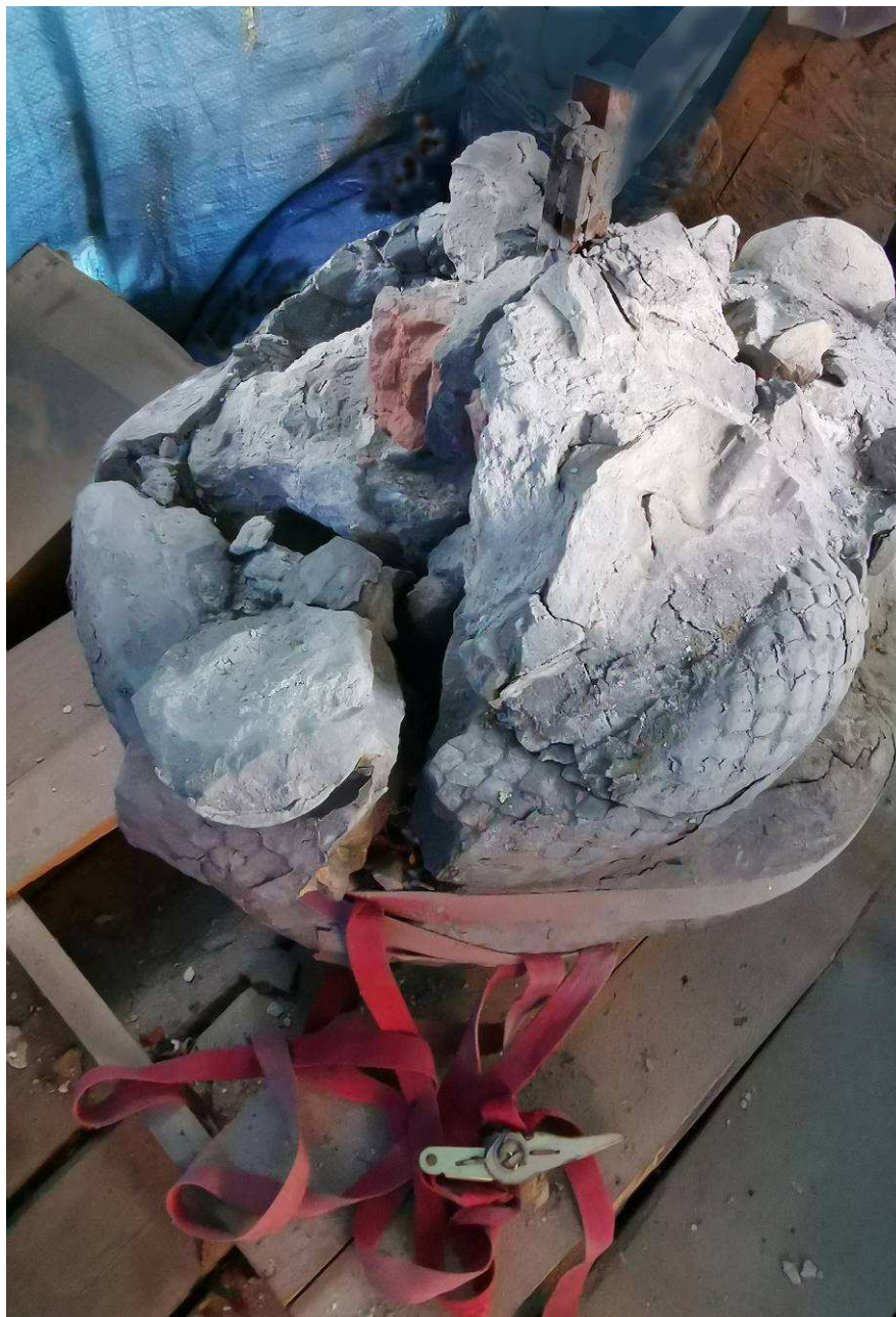
Fot. nr 22. Rozspojenie spękań w obrębie podstawy figury, wypełnionej w przeszłości betonem i cegłą.
