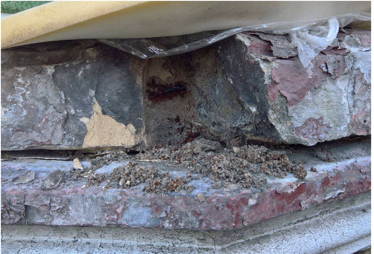
Fot. nr 18. Baza figury. Stan podczas demontażu w roku 2016. Czytelne korodujące zbrojenie uzupełnień ubytków oraz mokre, zdeintegrowane zaprawy.
