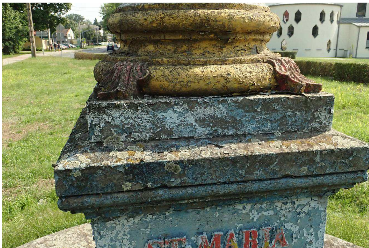
Fot. nr 33. Nakrywa postumentu z bazą kolumny właściwej. Stan zachowania. Widoczne nawarstwienia korozyjne kamienia, łuszczące się przemalowania oraz zasiedlenie mikroorganizmami.
